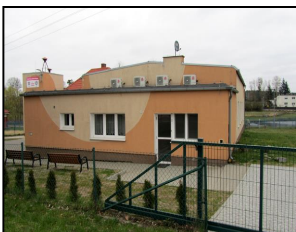
Świetlica wiejska oraz OSP
